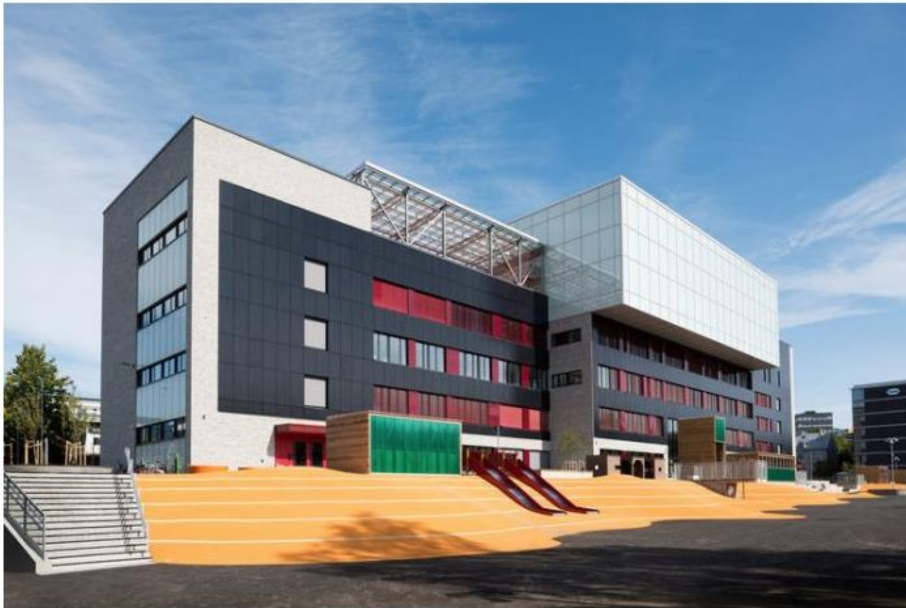
Brynseng skole har et av landets største fasadeintegreerte solcelleanlegg. Foto: Undervisningsbygg.
