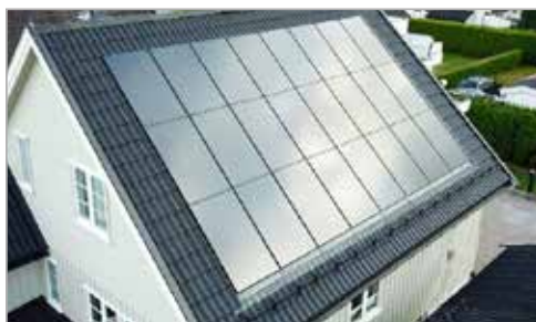
INTEGRERTE SOLCELLER kommer nå også på vanlige eneboliger. Disse skiller seg heller ikke vesentlig fra kjente elementer i bygningsmassen så som vinduer, takstein, panel og annet.
