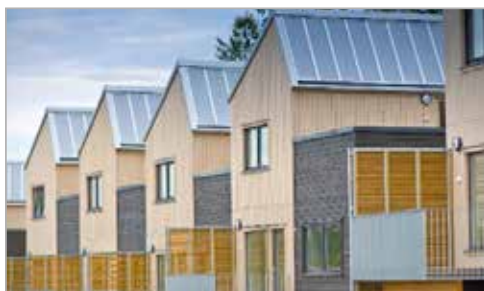
SOLFANGERE PÅ SKRÅTAK
