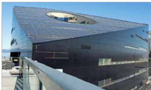
POWERHOUSE PÅ BRATTØRKAIA HAR SOLCELLER som dekker hele det skrå taket. Det er tatt hensyn til brann og redning ved etablering av solcellene.
